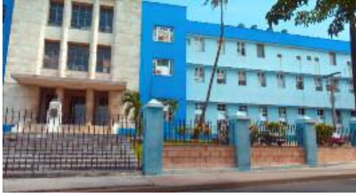
La reparación del hospital José Ramón López Tabranes ha sido priorizada con más de 2 000 000 de pesos.
