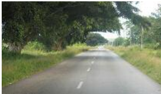
La Carretera Central, una de las siete maravillas de la ingeniería cubana.
