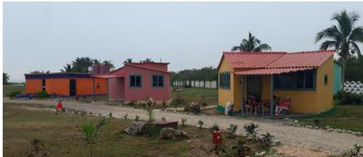
Tras el paso del huracán Irma, las cabañas fueron remozadas y hoy ostentan mejor imagen y confort.
